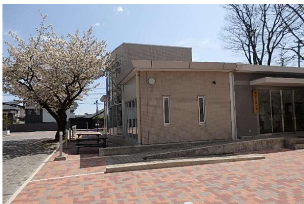
インターロックキング化が完了した多賀工業会館玄関付近
